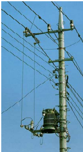
配電線 (6,600ボルト) 1.1マイクロテスラ (11ミリガウス) 〈測定ポイント：地表1m〉
