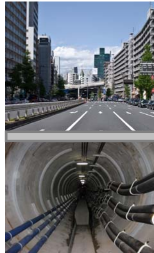
地中送電線 (15万4,000ボルト) 3.9マイクロテスラ (39ミリガウス) 〈測定ポイント：地表0.5m〉
